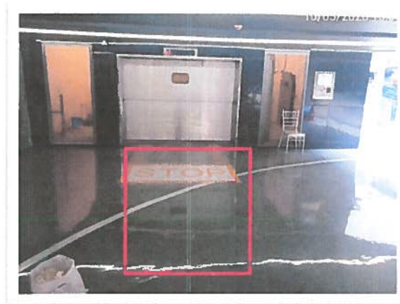
รูปที่ 3 แสดงบริเวณหน้าลิฟต์จัดจอดรถ
